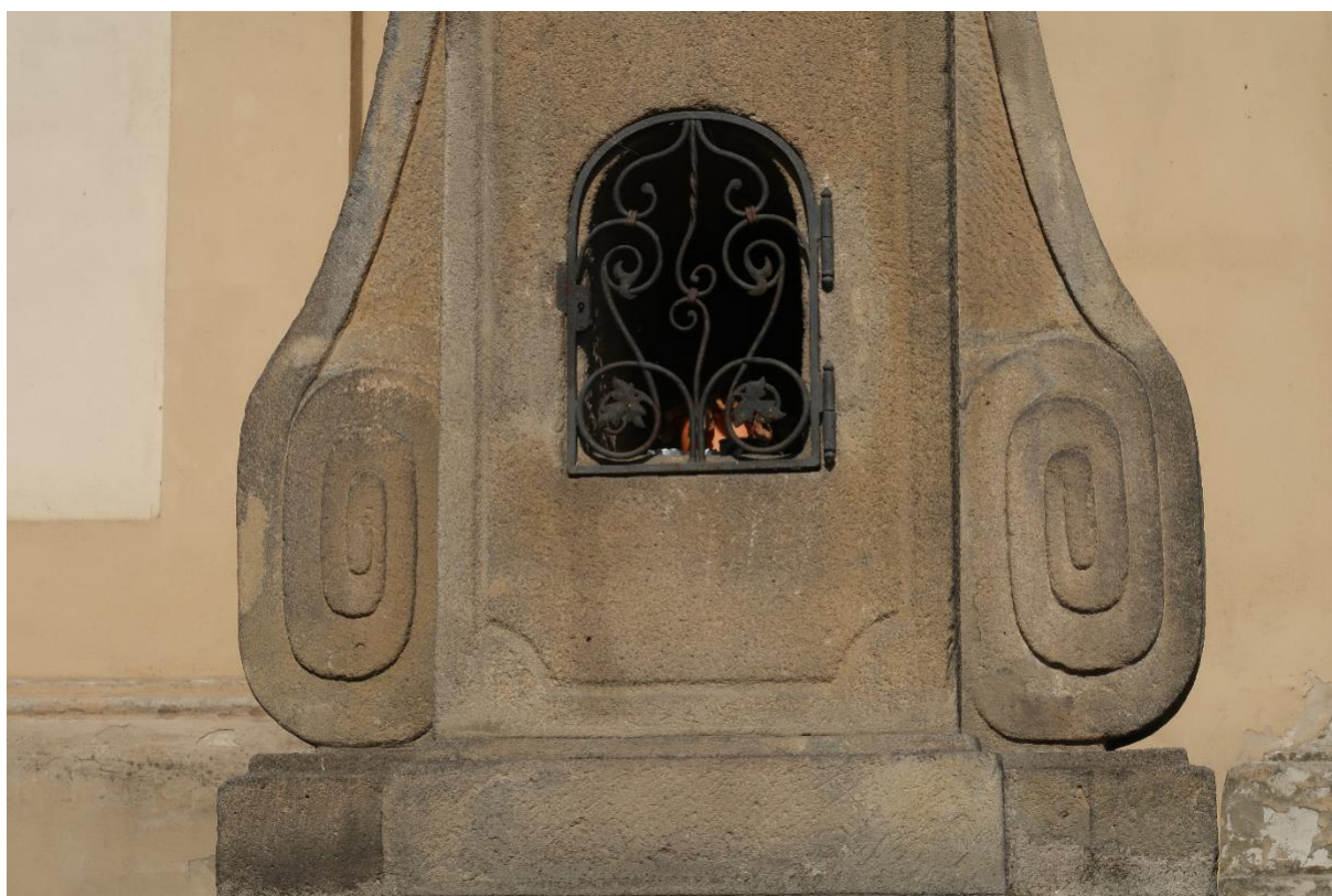
Stav před restaurováním – podstavec sv. Jana Nepomuckého, koroze kované mříže
