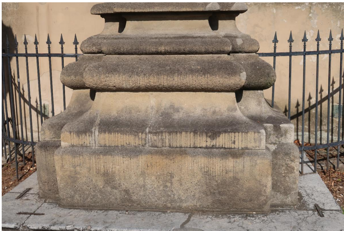
Stav před restaurováním – soklová část sochy sv. Jana Nepomuckého, usazené černé depozity
