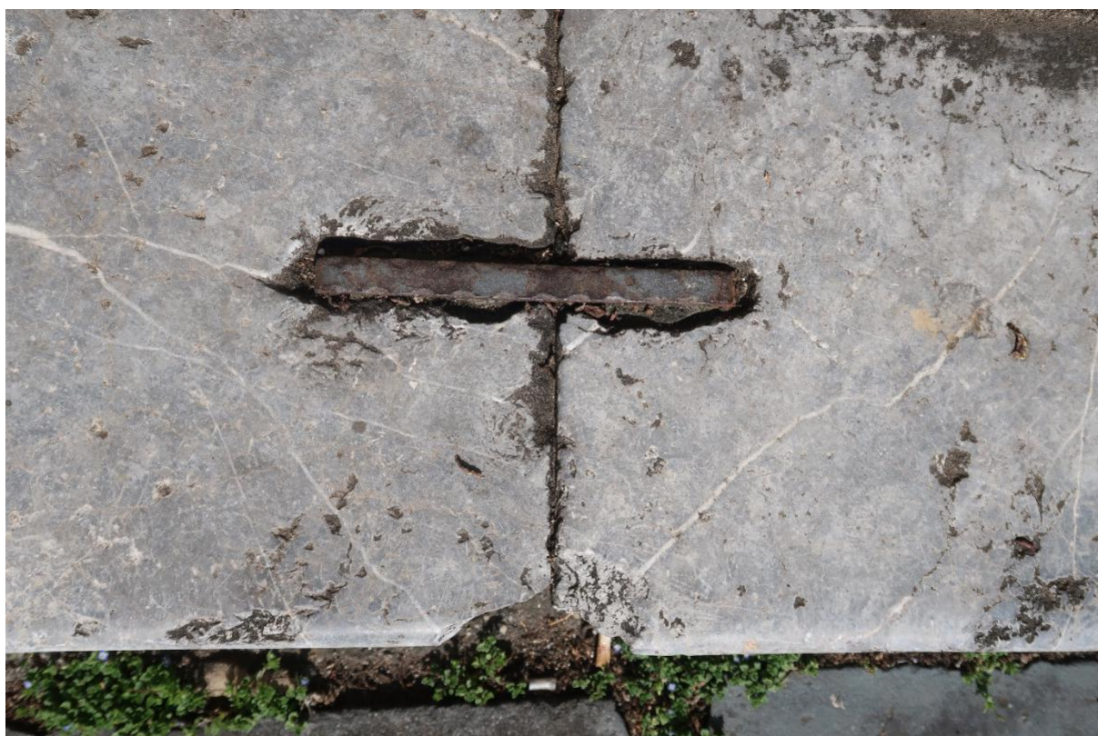
Stav před restaurováním – socha sv. Jana Nepomuckého, mramorový stupeň, korozivní změny železných kotev, uvolněné spáry
